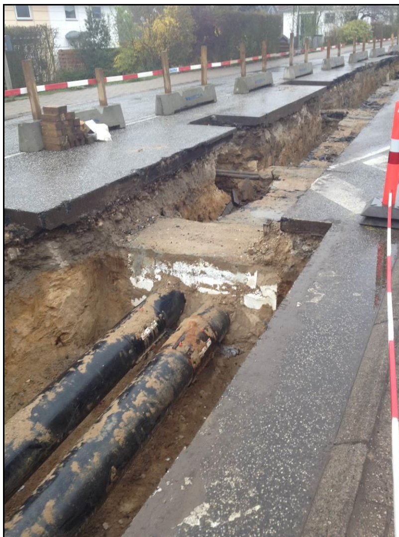
Udskiftning af betonkanal på Kingosvej
